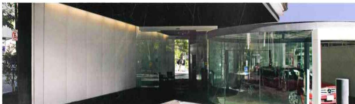
El área reducida del predio obligó a buscar una solución arquitectónica en la que se aprovechara al máximo el área por nivel. De esta forma surge el concepto del edificio: un gran marco hecho por dos placas de acero desfasadas entre sí que forman un volumen triangular socavado. Este volumen soporta un prisma de cristal flotado que contiene las áreas de oficina libres de columnas y con visuales direccionadas al Bosque de Chapultepec y a la colonia Polanco.
